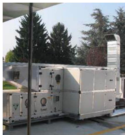
UTA unità trattamento aria
