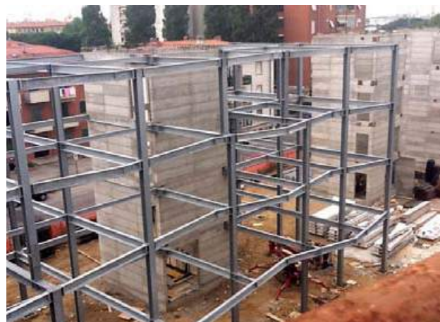
struttura in acciaio
