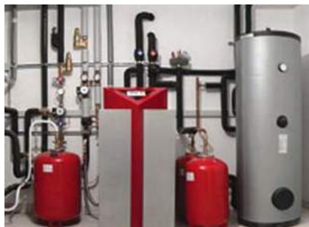
pompa di calore
